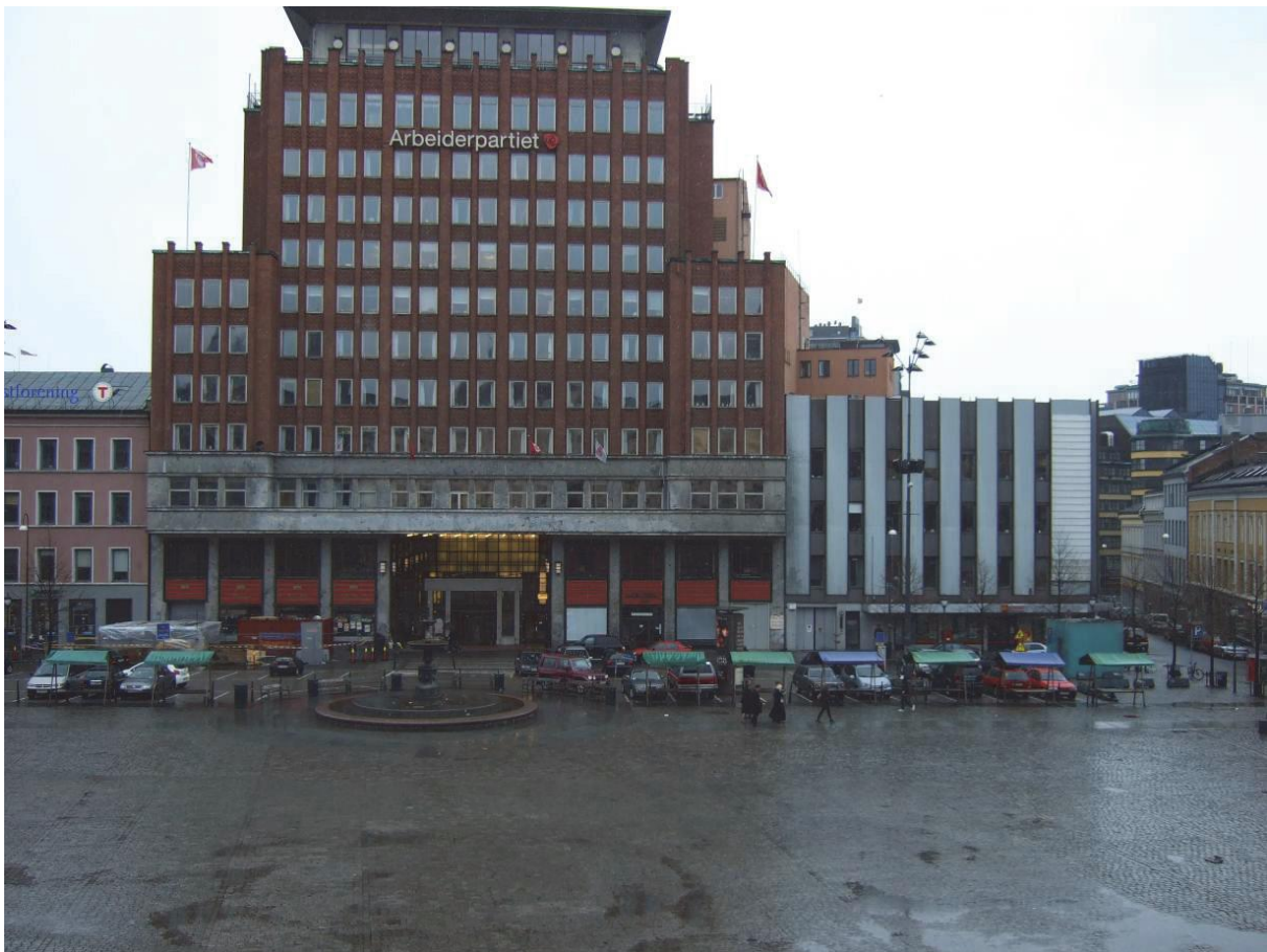
Figur 8: Planområdet i dag (eksisterende situasjon) sett fra Møllergata, hjørnebygget på bildets høyre side. Kilde: Forslagsstillers planbeskrivelse
