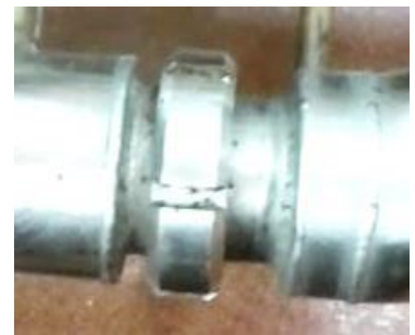
Figur 44: Eksempel på skjøt i produksjons-anlegget.
