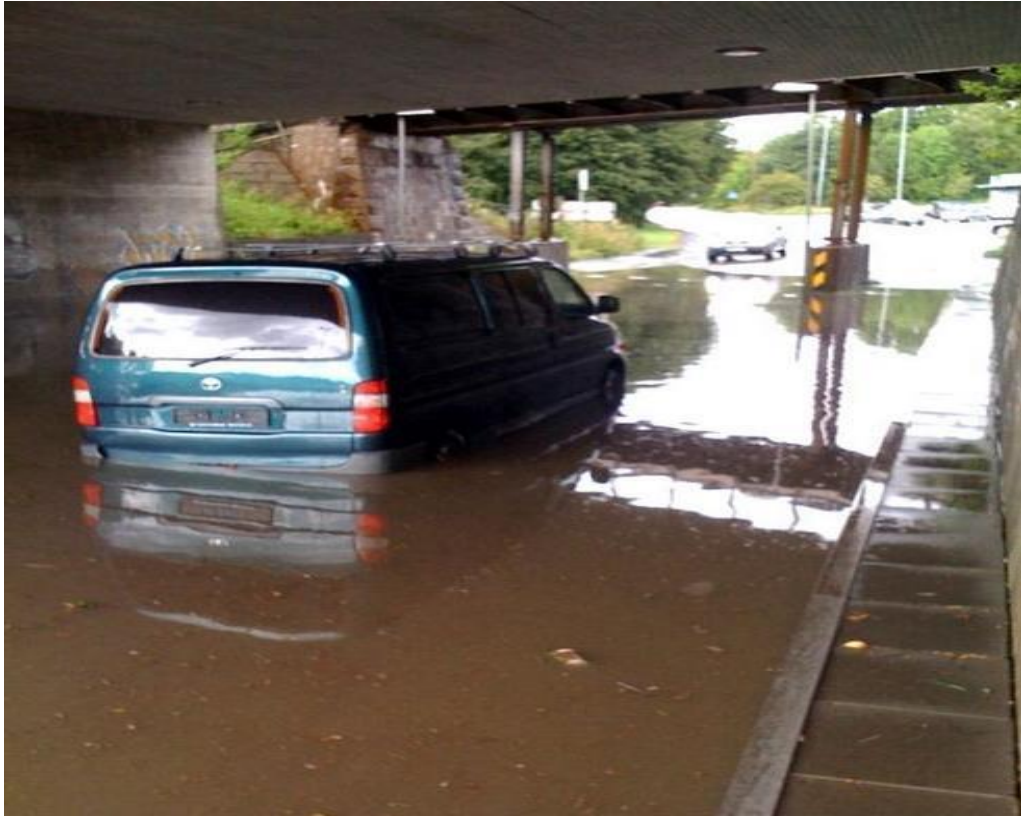
Figur 4.11: Oversvømmelse under jernbanelinjene ved Frydenberg VGS.(Kilde Fredrikstad Blad)
