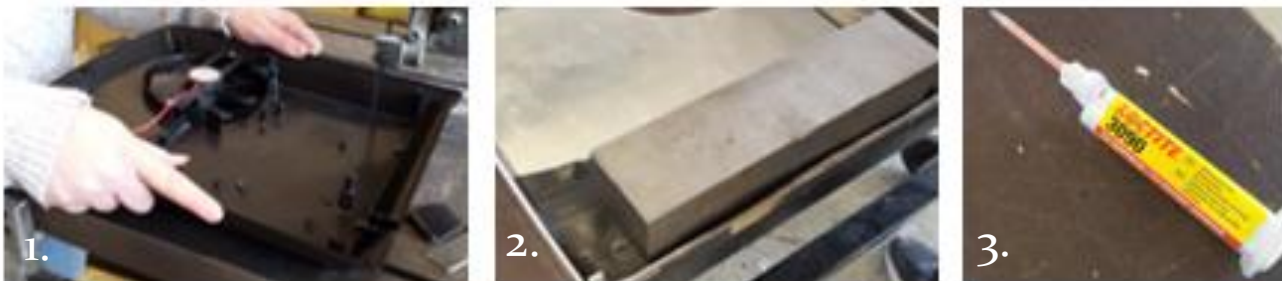
Figur 8.5.4: 1. Saging av plastdeksel med båndsag. 2. Påliming av gummistrier med Loctite 3090(3.). Eget foto.
