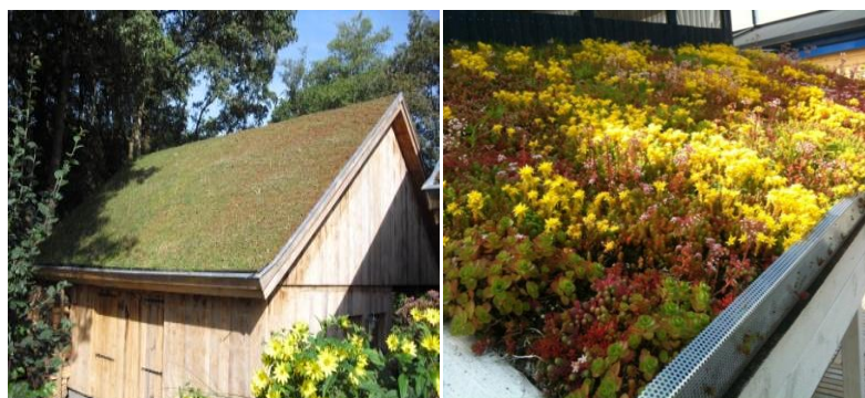
Figur 10: Sedumtak med fall. Foto: Vital Vekst AS (Vital Vekst AS)
