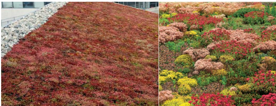
Figur 3: Ekstensive grønne sedumtak. Foto til venstre Svein Boasson (Boasson 2014). Foto til høyre ZinCo Norge AS (ZinCo Norge AS).
