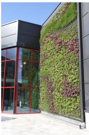
Figur 15: Norges første moderne levende utendørsvegg i Kristiansand, strekker seg fra innerom til uterom. Foto: Arvid Ekle/Anlegg og utemiljø AS (Blakstad 2014b).
