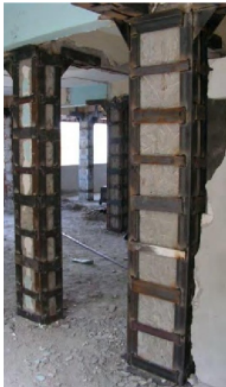
Figur 1: Steel jacketing på en betongsøyle [5]
