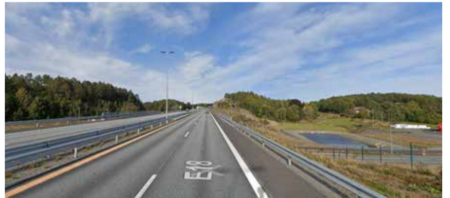
Figur 6-51 Basseng. Synlig i nordgående retning. (Bilde hentet fra google.no/maps).
