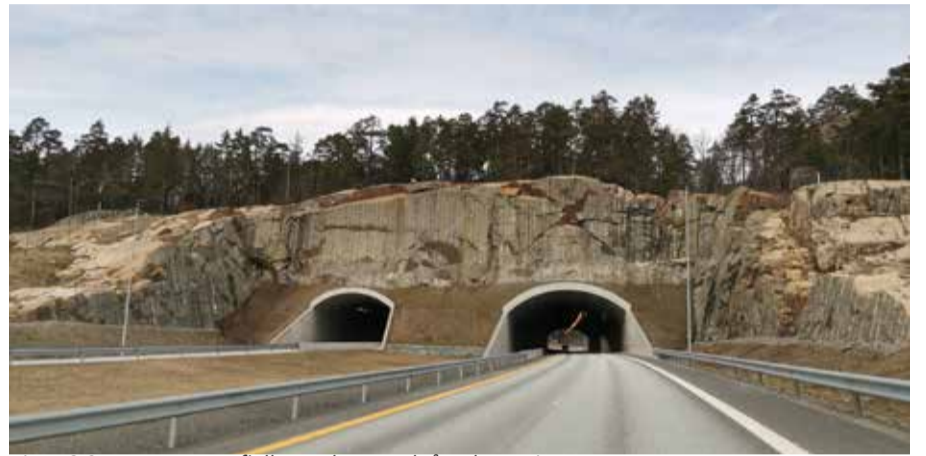
Figur 6-37 Træfjelltunnelen, nordgående retning
