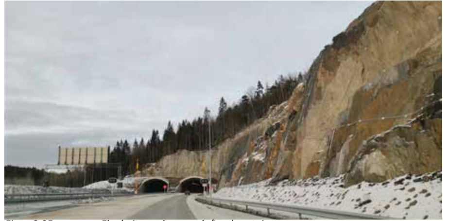
Figur 6-35 Fløyheitunnelen, nordgående retning
