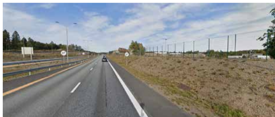
Figur 7-6 Voll som skjerner for industriområde ved Hesthagtunnelen. (Bilde hentet fra google.no/maps).
