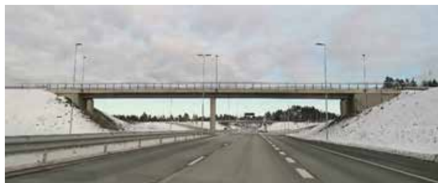
Figur 6-32 Anonym bru i betong
