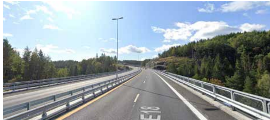
Figur 6-22 2, 187 meter lang og 23 meter høy. (Bilde hentet fra google.no/maps).
