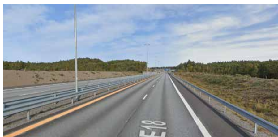
Figur 7-3 Voller før bru ved Øvre Piletjenn. (Bilde hentet fra google.no/maps).
