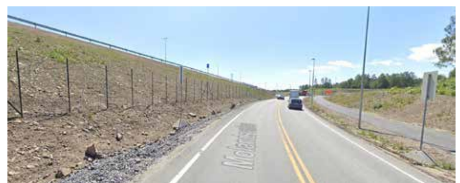
Figur 7-25 Fylling under E18 sett fra sidevei
