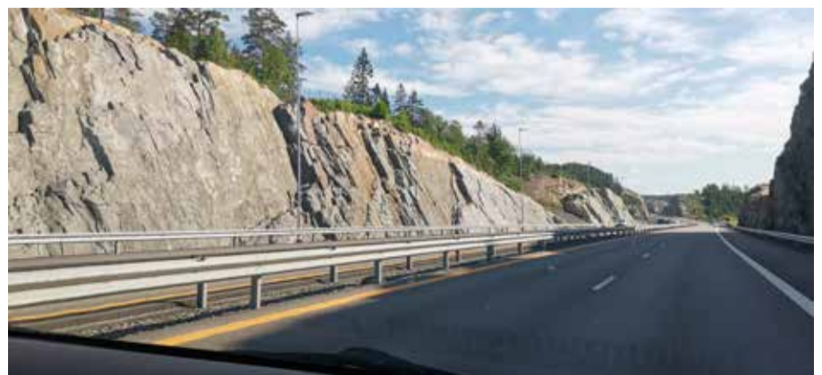
Figur 7-43 Fjellskjæring der man har fulgt de naturlige flatene i fjellet.
