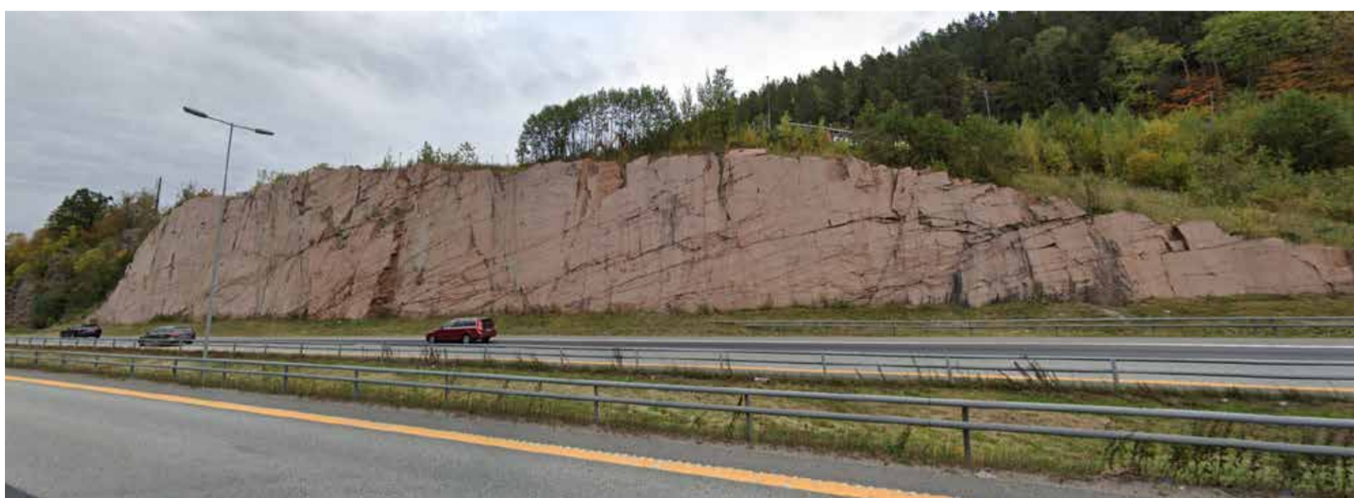
Figur 6-13 Fjellskjæring i Drammen. Eksempel på en god skjæring. (Bilde hentet fra google.no/maps ).
