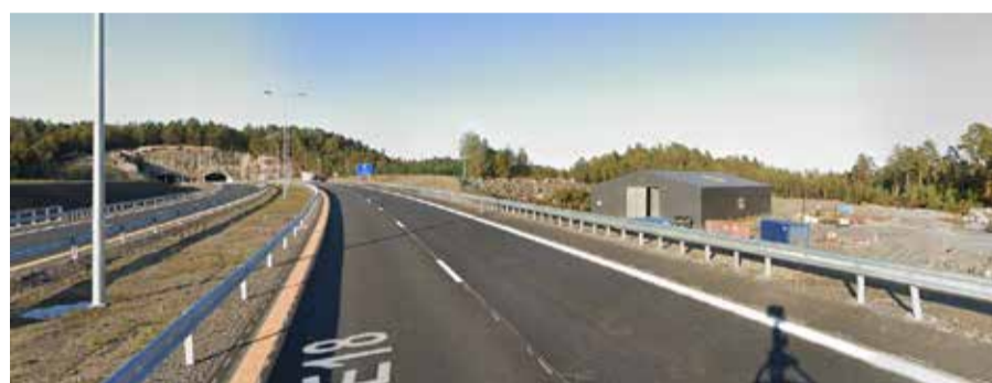
Figur 6-48 Lagerbygg. Synlig i nordgående retning. (Bilde hentet fra google.no/maps ).
