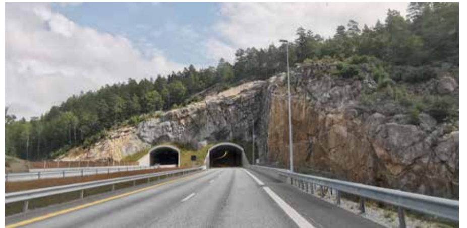
Figur 6-39 Hesthagtunnelen, nordgående retning
