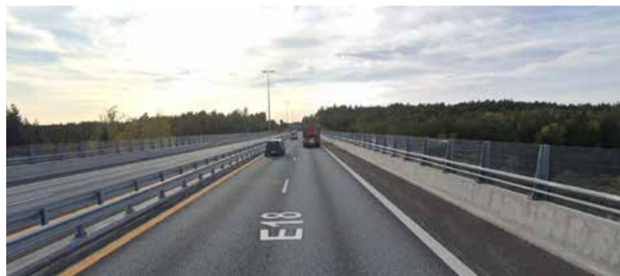
Figur 6-24 4, 185 meter lang og 20 meter høy. (Bilde hentet fra google.no/maps).
