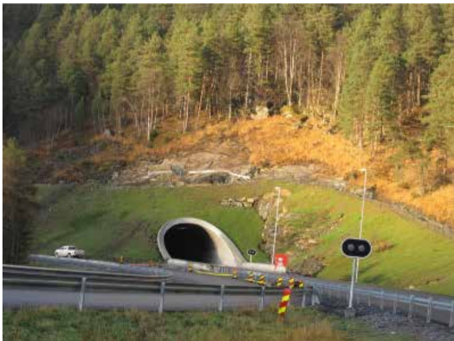
Figur 7-45 Tunnel ved Kvisisvegen. Tunnel som harmonerer med landskapet. Føler eksisterende landskapsform. Foto: Hanne Mørch (Hentet fra https://docplayer.me/47334062-Forelopig-utgave-per.html )
