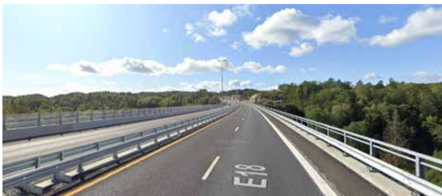
Figur 6-23 3, 208 meter lang og 30 meter høy. (Bilde hentet fra google.no/maps).
