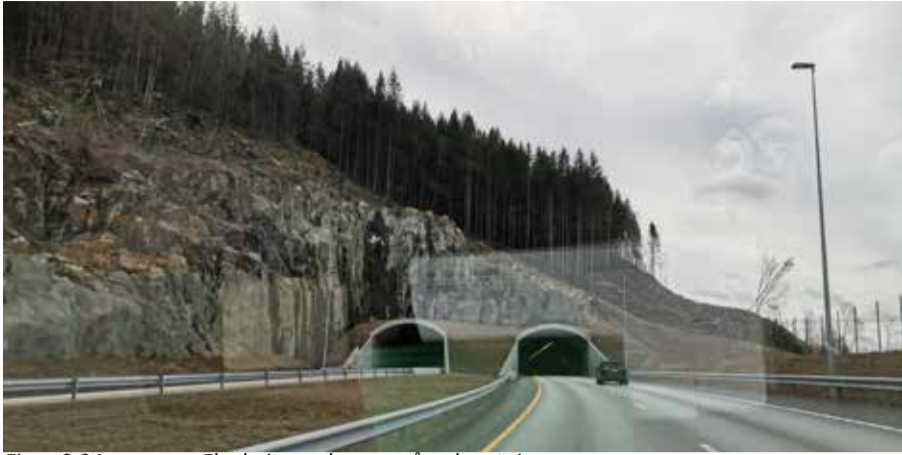
Figur 6-34 Fløyheitunnelen, sørgående retning
