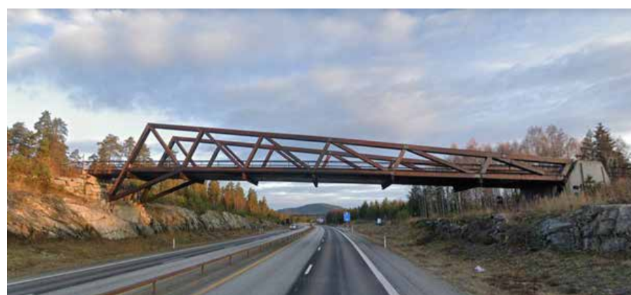
Figur 6-33 Bru som man legger merke til og som kan brukes som referansepunkt. (Bilde hentet fra google.no/maps ).
