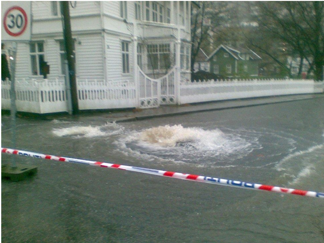
Figur 5 Kapasiteten i avløpsnettet er sprengt og trykkehøydeforskjell i nettet gjør at vannet strømmer opp til overflaten. Foto: Morten Wanvik Hentet fra: (Engan 2014)
