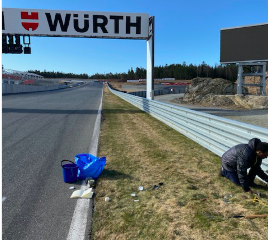
Figur 3.3: Grøftene langs banen var dekket av gress. Her ved start/mål (prøvepunkt 1). Foto: Helena Marie Amdal
