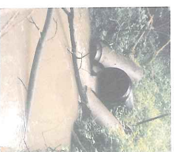
Ved planering ble en bekk lagt i rør. Bildet viser plastledning i utløpet med de utrangsjerte betongrør på siden.
