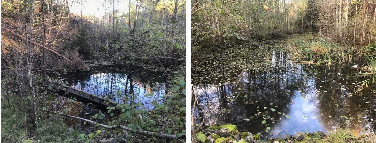
Figur 3. Frogn rensedbasseng. Består av to kammer; forsedimentasjonsbassenget til venstre og hovedbassenget til høyre. Bildene er tatt fra midtpartiet mellom bassengene. Midtpartiet bestod av grus.
