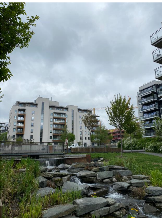
Figur 4: Ny boligbebyggelse ved Gladengveien (Ensjø nord).
