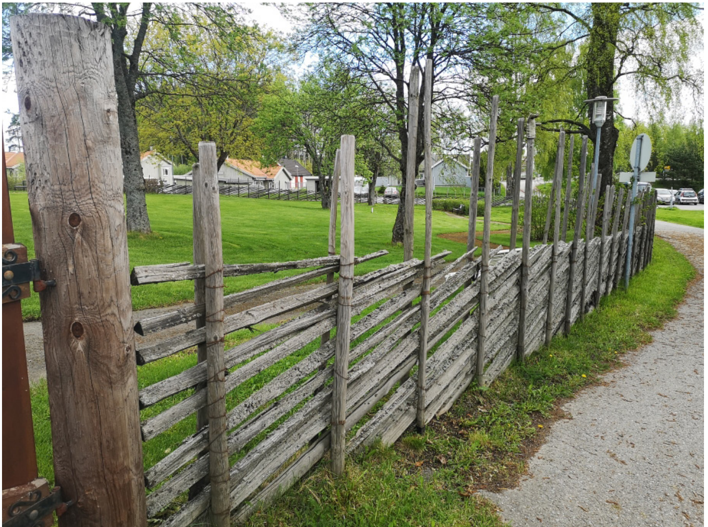
En skigard står som den fysiske skjermingen i dag. Visuell skjerming er fraværende.
