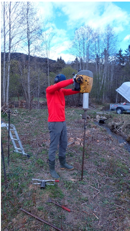
Figur 3-4 Montering av brønn 4003. Boringen kan gi svar på egenskaper til løsmassene det bores gjennom. Foto: Leif Vidar Jakobsen.
