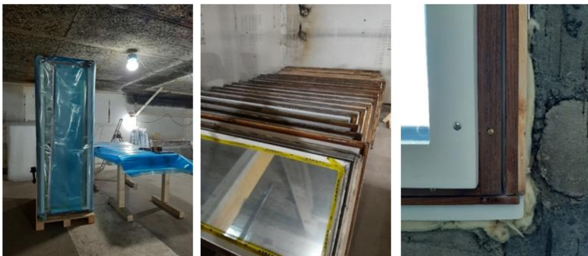
Figur 4.4.2 Eksisterende vinduer i prosjekt. Eget foto ette befaring 20. mai 2020
