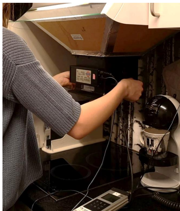
Figur 3-24: Måling av luftmengder gjennom kjøkkenventilator ved hjelp av SwemaAir 300 og måletrakt tilpasset kjøkkenhetter.
