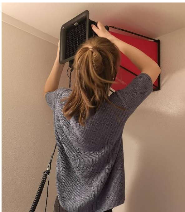
Figur 3-23: Måling av luftmengder gjennom avtrekksventil ved hjelp av SwemaAir 300 og SwemaFlow 125.
