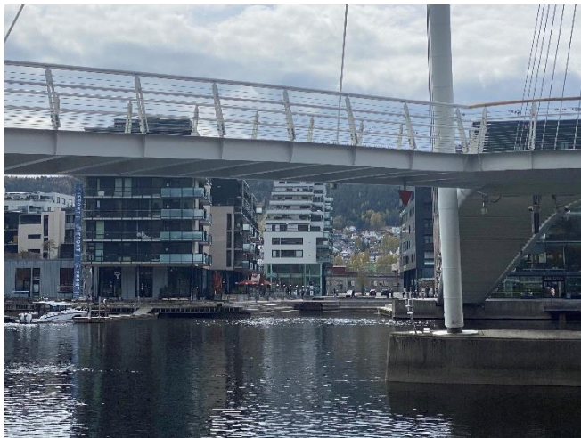
Figur 44: Det åpne byrommet sett fra bydel Bragernes
