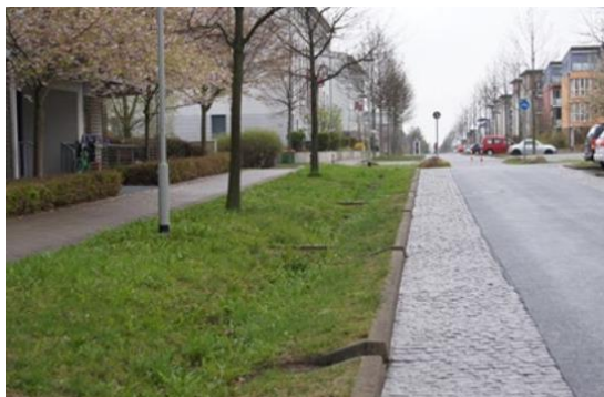
Figur 7: Infiltrasjonsgrøft langs vei. (Gabriel & Fiil, 2016b)
