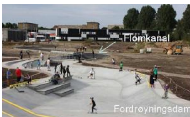
Figur 15: Skateplass som fungerer som et tilrettelagt oversvømmelsesareal (Åstebøl et al., 2013).
