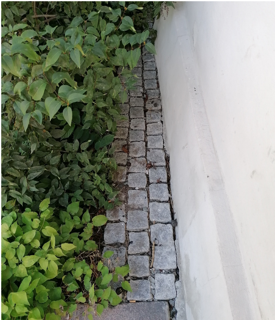
Figur 46. Kantstein på baksiden av bed inntil fasaden.
