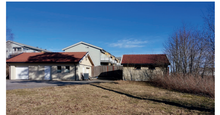
Figur 72. Rekkehusbebyggelse i bakgrunnen og eksisterende bebyggelse som skal fjernes i forkant.
