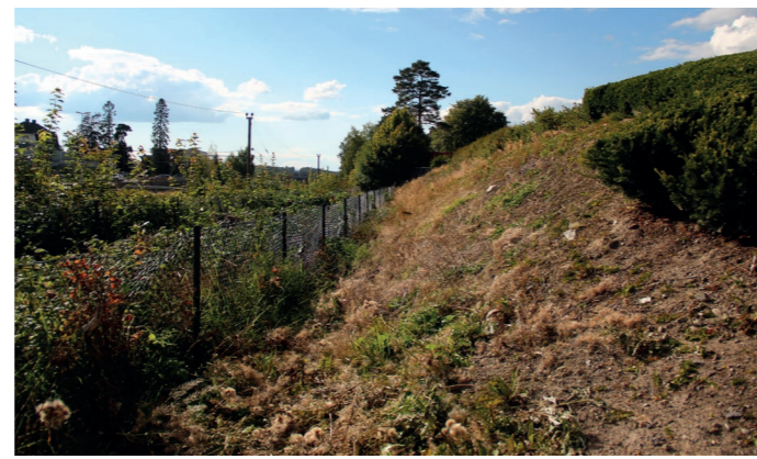
Figur 70. Løsmasser med fare for skred i o_Park5
