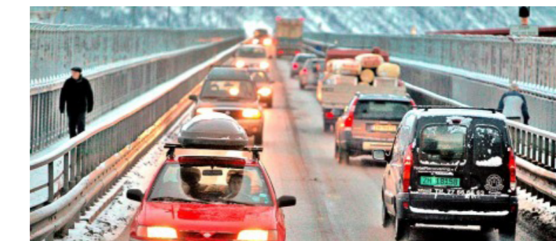
Fig 23. Tromsøbrua er den viktigste forbindelsen for fotgjengere og syklist fra Tromsdalen til Tromsøya (tv2).
