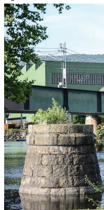
67) Fundament fra tidl. jernbane
