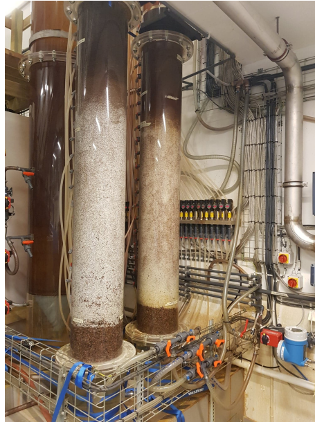
Figur 3.2: Et bilde av deler av pilotanlegget. Filterkolonnen til høyre i bildet var i drift. Sedi- menteringskolonnen er til venstre i bakgrunnen.
