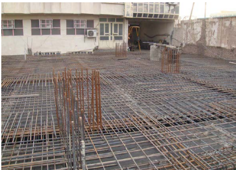
Figur 14 - Dekke på grunn med armering, uten isolasjon
