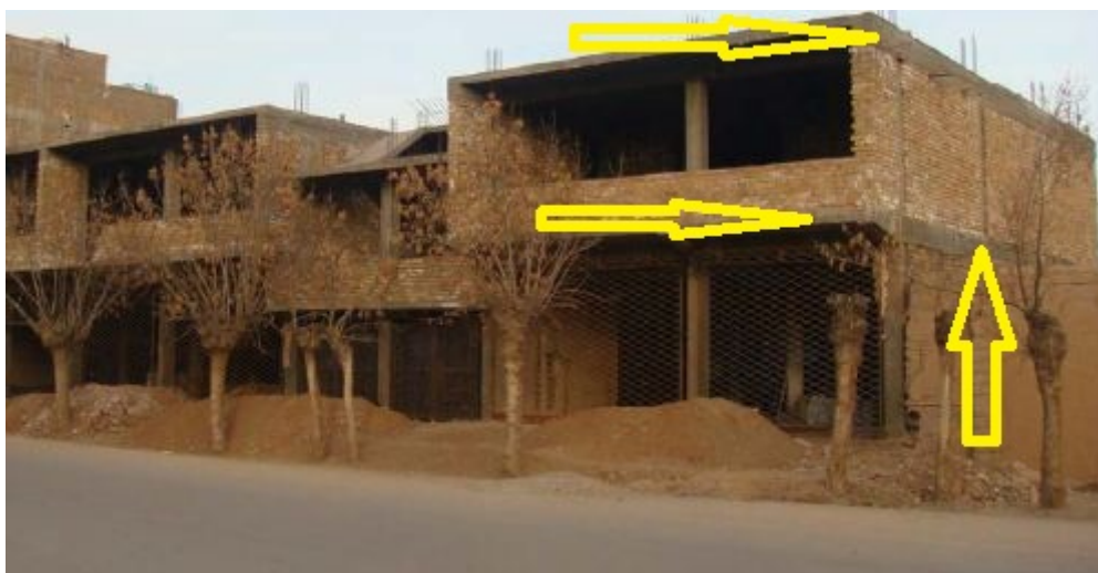
Figur 17 - murverksbygg med armert betong som bæresystem
