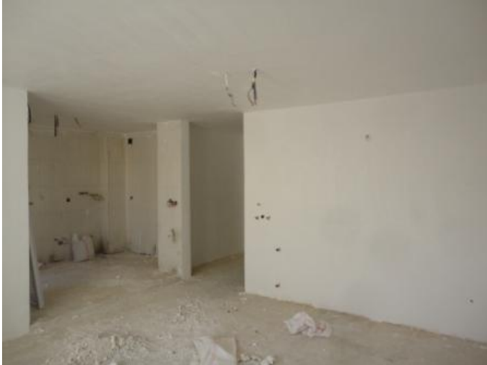
Figur 13 - 10mm gipsslag sparkles på halmleire-overbehandlede overflater
