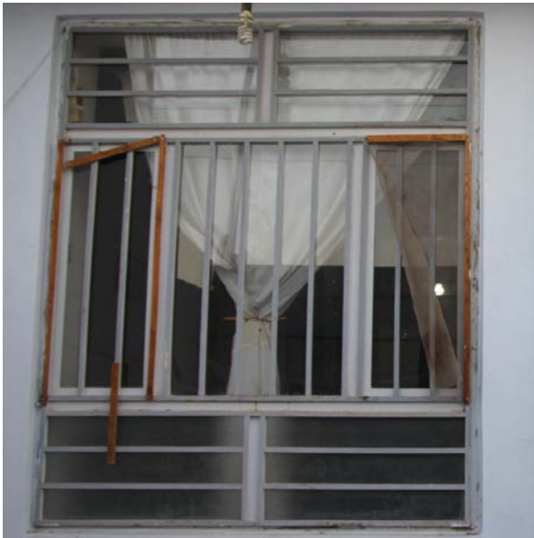
Figur 15 - Vindu med stålandel lik 0,35 og resten vanlig 4mm glass.
