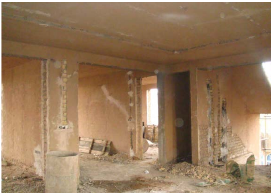
Figur 12 - Halmleire sparklet på alle innvendige overflater utenom gulvet
