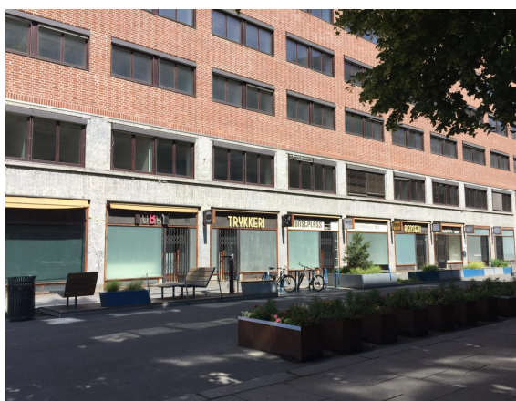
Figur 3.49: Solforholdene i Rosenkrantz gate 23. juni 2020 kl. 11:02.
