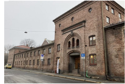
Figur 3.72: Myntgata 2 er et flott, fredet bygg, men har ikke en inviterende fasade ut mot Nedre Slottsgate. Vinduene sitter høyt og det kun er en dør på det 113 meter lange bygget, og det kategoriseres derfor som «kjedelig».
