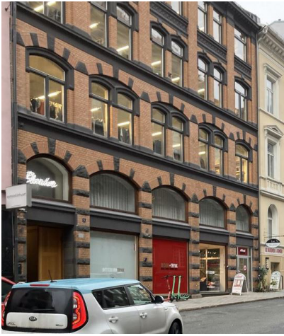
Figur 3.66: Nedre Slottsgate 5 har en detaljert fasade med store vinduer i første etasje, men flere av disse er tildekket, og fasaden kategoriseres derfor som «midt mellom».
