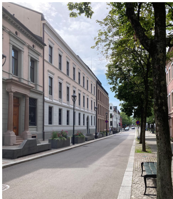
Figur 4.7: Kirkegata, to kvartaler øst for Nedre Slottsgate, fremstår forseggjort og hyggelig med ordentlig asfalt, lyktestolper, gatetrær og terrorsikring i form av tunge benker og blomsterkasser.
