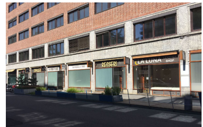
Figur 3.40: Tordenskiolds gate 12 mot Rosenkrantz gate er klassifisert som «Prioritert kulturminne». Bygget er under renovasjon og fasaden er derfor vurdert til å være «inaktiv». Fasaden tilfører i dagens situasjon lite til gaten, men dørene ligger tett, noe som etter Gehls skala kunne gitt høy score om bygget hadde hatt innhold. Første etasjen har også store vinduer som gjør det til en potensielt aktiv fasade.
