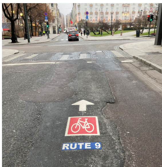
Figur 3.58: Gaten er merket som sykkelrute 9, men har ikke eget sykkelfelt og ujevn asfalt.
