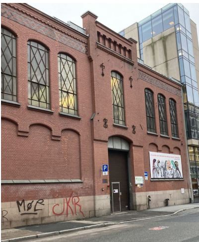
Figur 3.34: Rosenkrantz gate 14 er regulert til bevaring og har en forseggjort arkitektur, men en lite inviterende fasade, med førsteetasje uten vinduer. Fasaden kategoriseres som «kjedelig».
