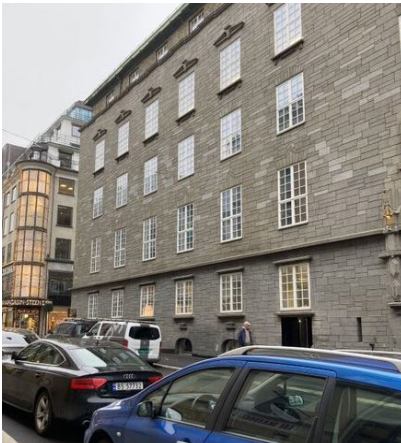
Figur 3.67: Nedre Slottsgate 6A-6C er et stort bevaringsverdig bygg. Fasaden er massiv med få dører og vinduer høyt på veggen, den fremstår med dette lite inviterende fra gateplan og kategoriseres som «kjedelig».
