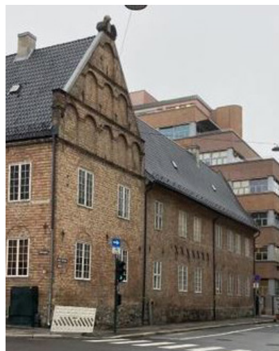
Figur 3.70: Rådhusgata 19 er et vernet bygg, sett fra Nedre Slottsgate er fasaden lite inviterende uten dører og med vinduer høyt på veggen. Fasaden er kategorisert som «kjedelig».
