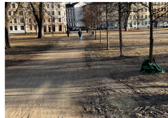
1 Dårlig vedlikeholdt grussti gir et ujevnt underlag.
