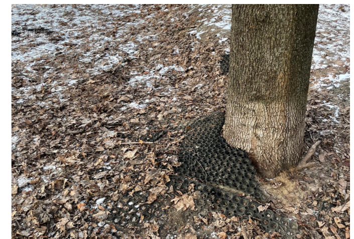
2 Armert gress med unøyaktige skjæringer rundt trestammer og kumlokk.
