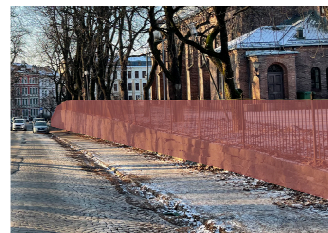
5 Høy mur mot Rathkes gate.
