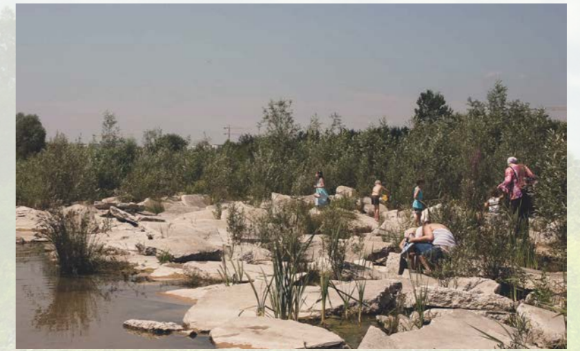
Figur 2.30. Vegetasjon vokser til mellom brutte betongelementer. (Foto: GTL)
