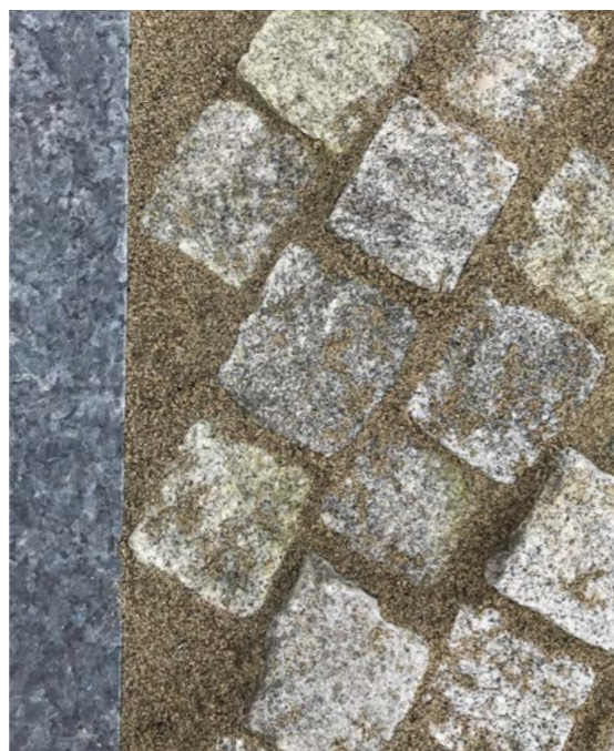
Figur 4.34. Vi har testet den alternative løsningen for overgang med smågatestein mot granitthelle.
