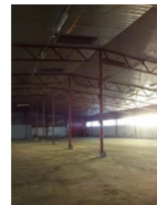
Figur 4.10. Stålkonstruksjon og bølgeblikk, Ensjøveien 10.
