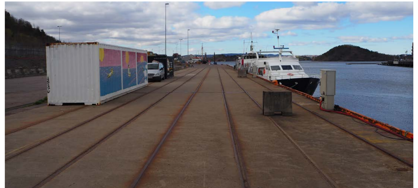
Figur 4.18. Eksisterende betongdekke med rilleskiner.
