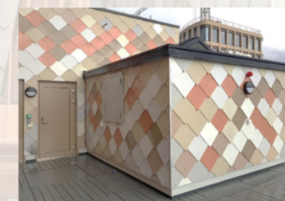
Figur. 2.23. Gjenbruk av stålplater på fasaden (Foto: Egeberg, J.R. / Asplan Viak)
