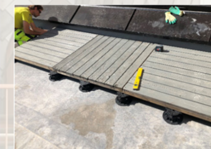
Figur. 2.24. Gjenbruk av tremmegulv (Foto: Andersen, R. / Insenti)
