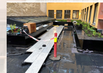
Figur. 2.22. Underveis i leggingen av dekket (Foto: Andersen, R. / Insenti)
