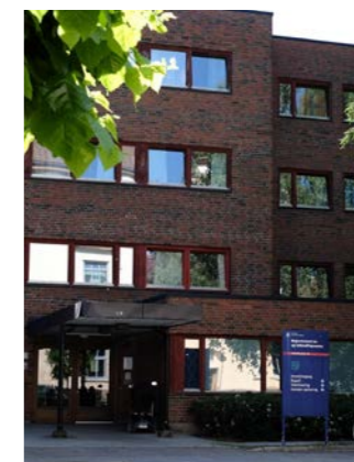
Figur 4.9. Teglfasade og vindu, Majorstutunet bo- og behandlingssenter.
