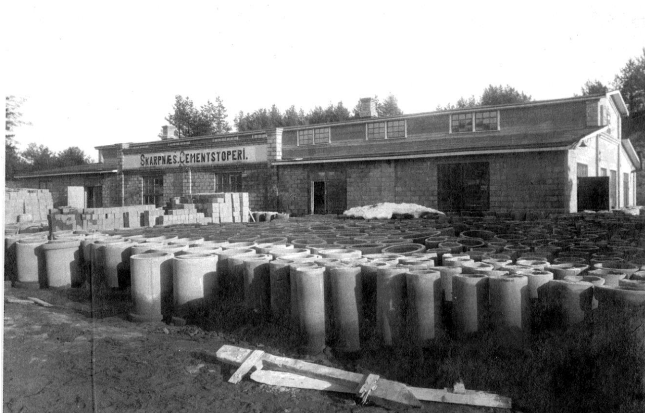
Figur 2 – Skarpnes Cementstøperi etter overtakelsen av Jens og Sigvart Tveite.
