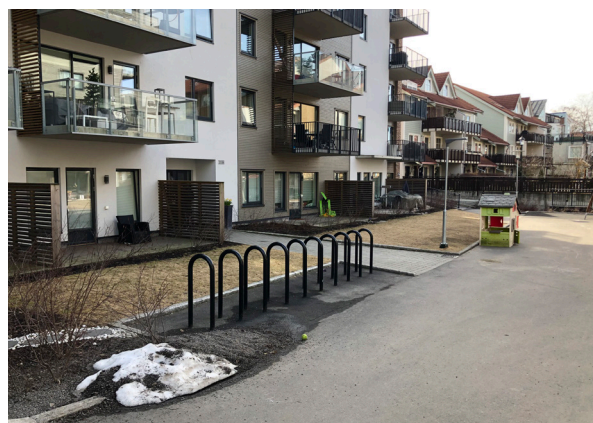
Bilde 25: Manglende skjerming mellom private terrasser og fellesareal i Fjellgata 30.
