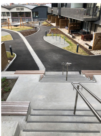
21: Trapp til uteoppholdsarealet ned fra Malerihaugveien. Bufferareal mellom private terrasser og fellesareal.
