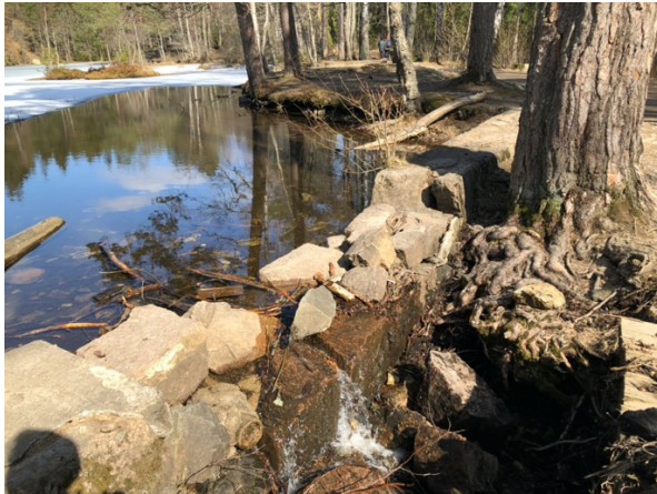
Figur 3.17 Utløpet fra Båntjern kan oppgraderes med et V-formet utløp. Dette vil holde normalvannstanden som i dag, men også bidra til å holde tilbake mer vann ved store nedbørhendelser. Det er muligheter for en midlertidig heving på ca. 0.4 meter.
