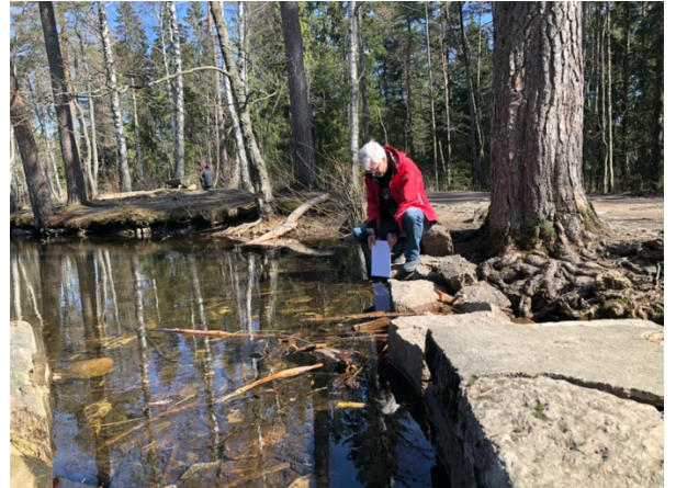
Figur 3.17 Utløpet fra Båntjern kan oppgraderes med et V-formet utløp. Dette vil holde normalvannstanden som i dag, men også bidra til å holde tilbake mer vann ved store nedbørhendelser. Det er muligheter for en midlertidig heving på ca. 0.4 meter.
