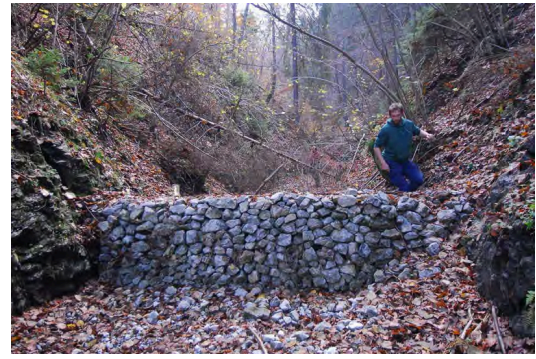
Figur 1.10 Eksempel på for små stein (foto K.A Hoseth)
