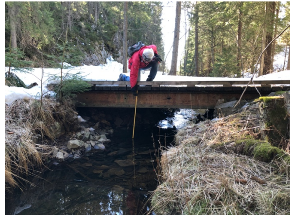
Figur V.18 Venstre side viser motstrøms, her kan fordrøyningsanlegget ligge ca. 1 meter over normalvannføringen. Høyre side viser nedstrøms side, her ligger det ei bru med fri høyde 0.7 meter. Det sees også her at vannet har greid å erodere sidene under brua.
