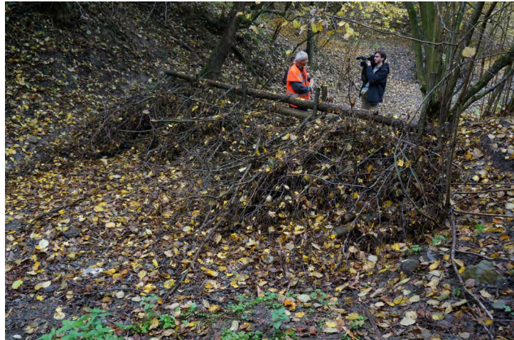
Figur 1.8 Kvistene kan legges mot sidekanter og bunnen. Vannhastigheten vil senkes i det området og erosjon i bekkkantene minimeres. Vannstrømmen vil fortrinnsvis ledes sentralt i anlegget (foto K.A. Høseth) (Braskerud et al., 2014).
