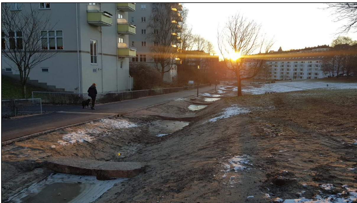
Illustrasjon 10: Kulper for håndtering av overvann i Iladalen park og fra taknedløp og harde flater i Vøyensvingen Borettslag. Kilde: Dronninga, 2021.
