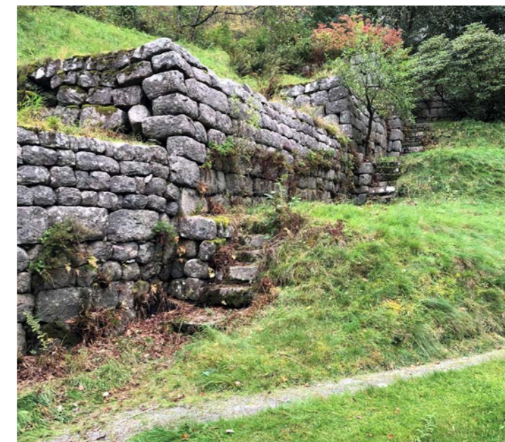
Figur 6.21 De to midterste murene er i dårligst stand og må stabiliseres
