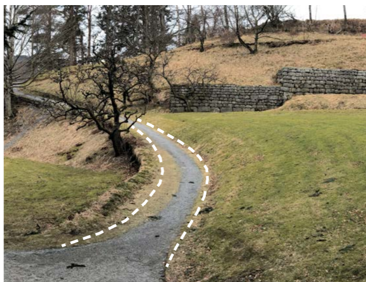
Figur 6.13 Veien ved Alsbraatet bør gjøres bredere og få bedre sidefall
