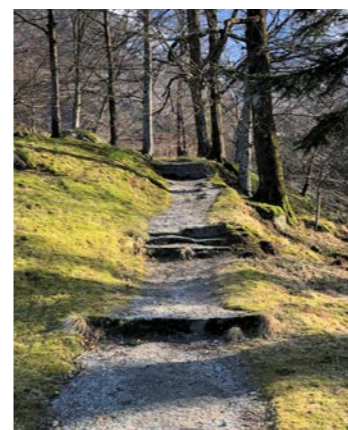
Figur 5.21 Ujevn bredde og grus som sklir ut
