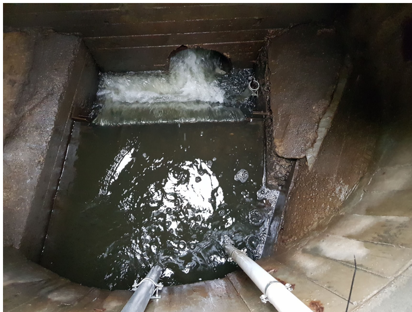
Figur 3.5: Målekum med tverrsnitt.
