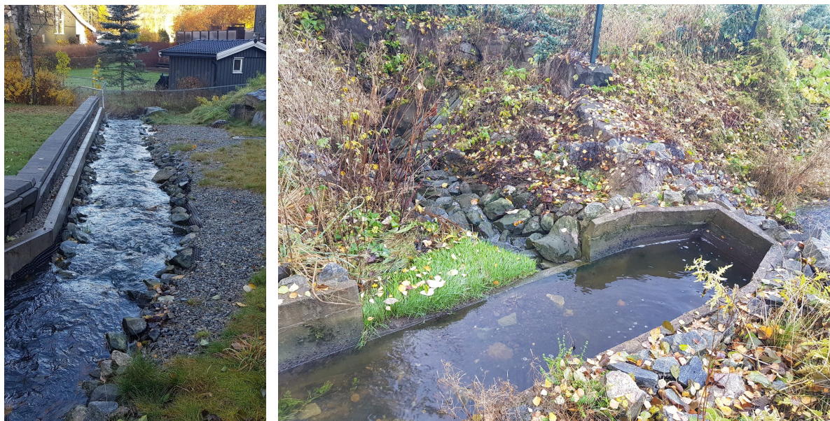
(a) Opparbeidet bekkeløp.
