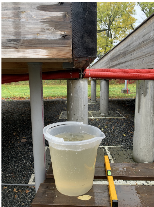
Figur 3.9: Måling av lekkasje. Foto: Peter Andreas Bassøe.
