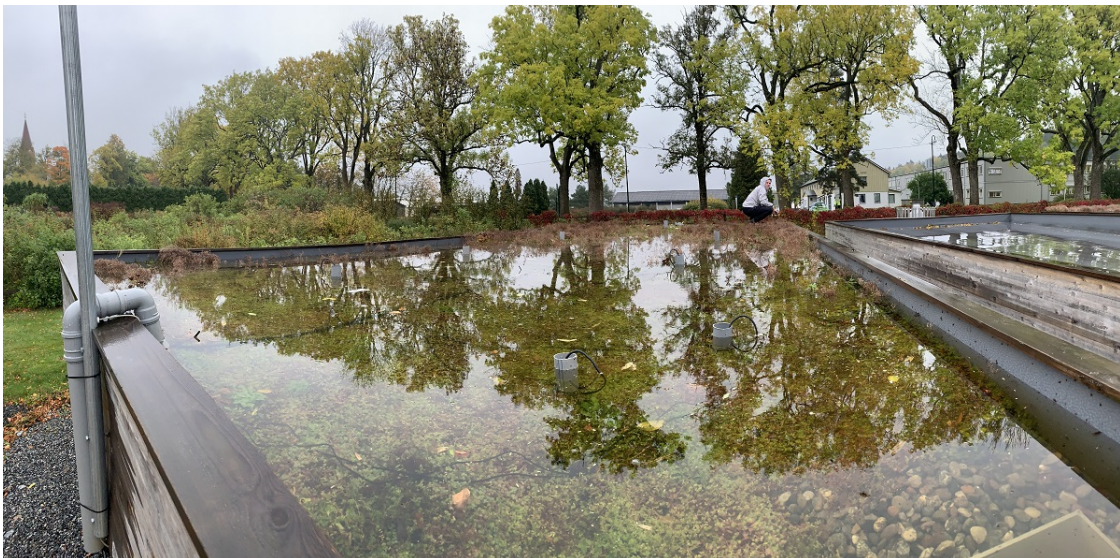
Figur 3.13: Fritt vannspeil ved fylling. Foto: Peter Andreas Bassøe.
