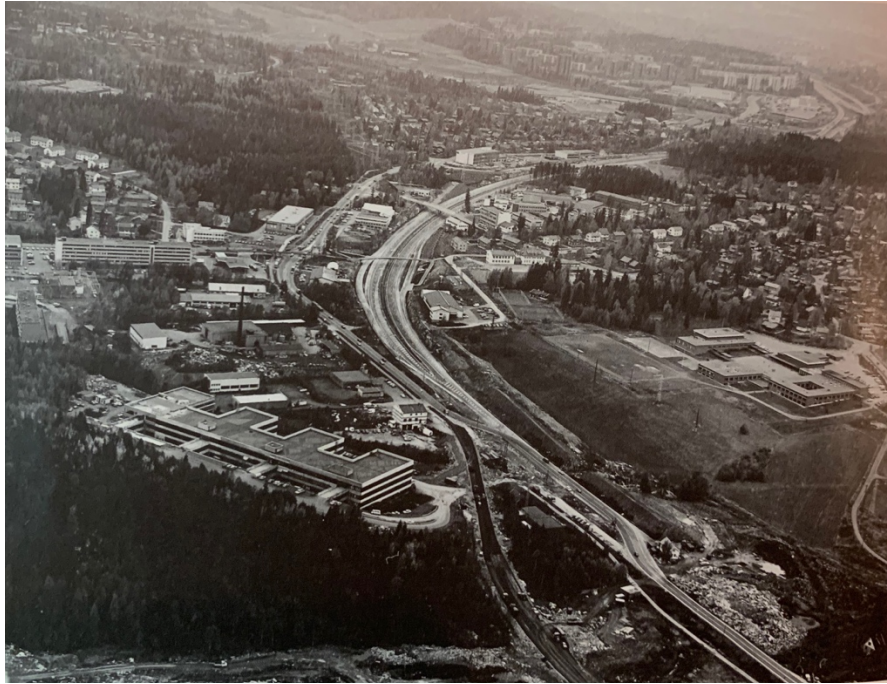
Figur 16: Flyfoto fra 1982 med panorama over den vestlige delen av Lørenskog. Den nye fire-felts Strømsveien dominerer bilde og skjærer seg gjennom landskapet til Lørenskog. (Kilde: Alsvik, 1998, s.436)
