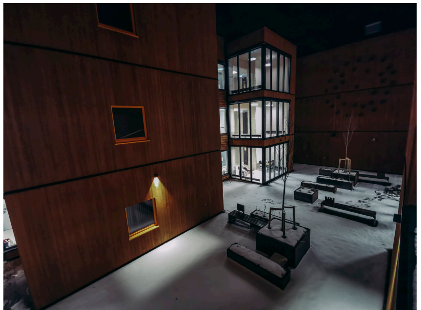
Fig 117: Belysningen i atriene er god med vertikal belysning fra vegger og vinduer. Fotograf: Alta kommune
