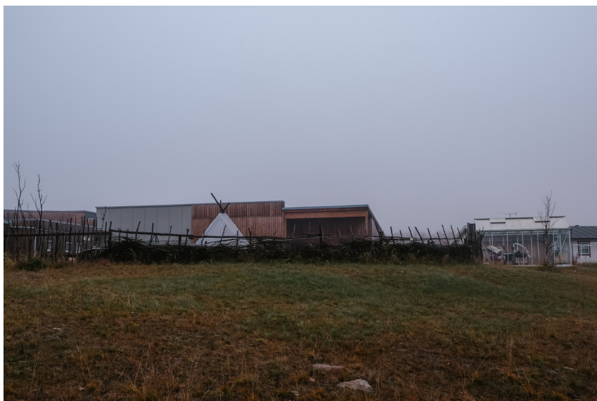
Figur 62: Dorvogoahti ligger på en høyde over omkringliggende helsebygg med utsikt over Kautokeino tettsted og Kautokeinoelva
