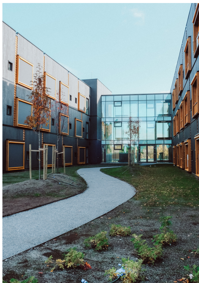
Fig 144: På nordsiden har mange beboere utsikt inn til hverandre, og en føler seg noe overvåket både når man spaserer i sansehagen. De gode effektene av vindusutsikten blir også borte fra beboerrommene.
