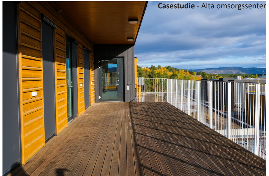
Fig 99: Store terrasser og verandaer ut fra fellesrom ved alle avdelinger
