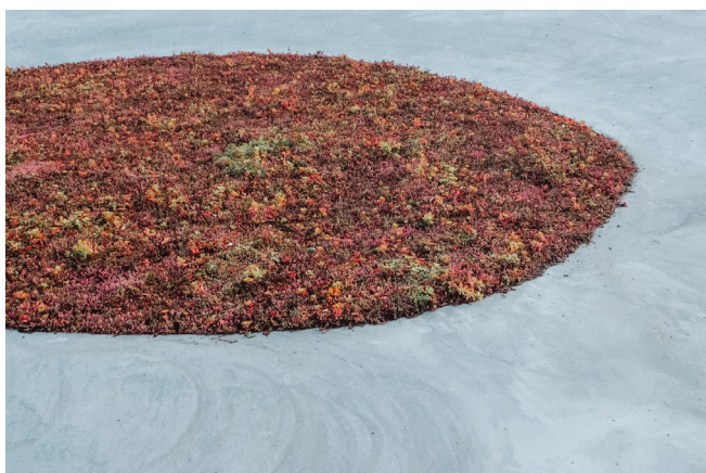
Fig 127: Børstet betongdekket rundt sedumbed ved Alta omsorgssenter. Ingen hevede kanter
