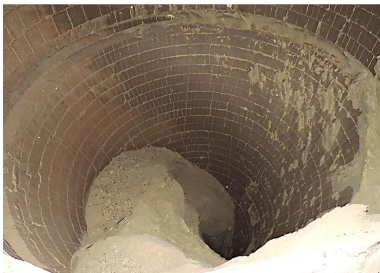
Figur 5: Sintring i syklon i Riikinvoima-anlegget observert etter 10 uker i drift ved bruk av natursand som bedmateriale. Foto: Eurofins Expert Services.
