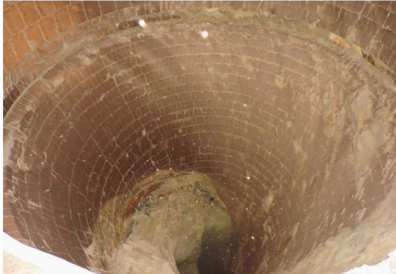
Figur 6: Sintring i sykklon i Riikinvoima-anlegget observert etter 15 uker i drift med GR-Granul som bedmateriale. Foto: Eurofins Expert Services.
