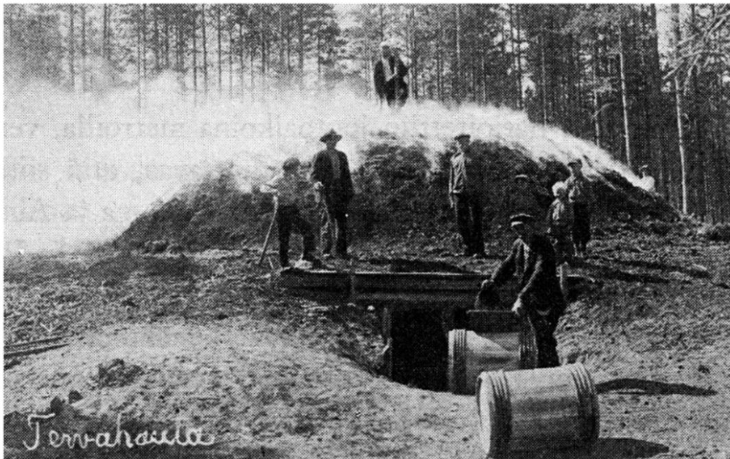
Figur 11: Bildet viser brenning av tjæremile i Finland omtrent år 1900. (Kanto, u.å)
