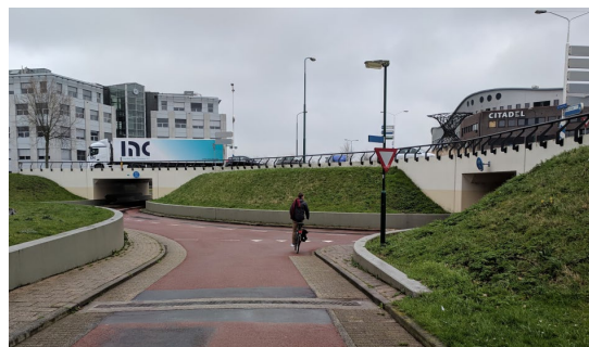
Figur 3.25. Eksempel på kryss der undergang separerer syklister fra bilister (Georgiatech, u.å.)
