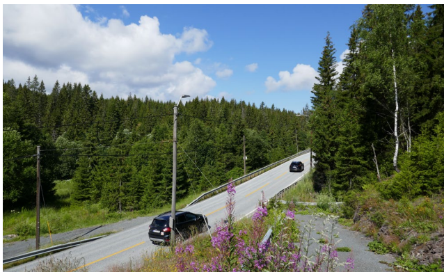
Figur 5.5. Eksisterende E16 før utbygging med Avtjernaområdet som skrå oppover på østlige siden
