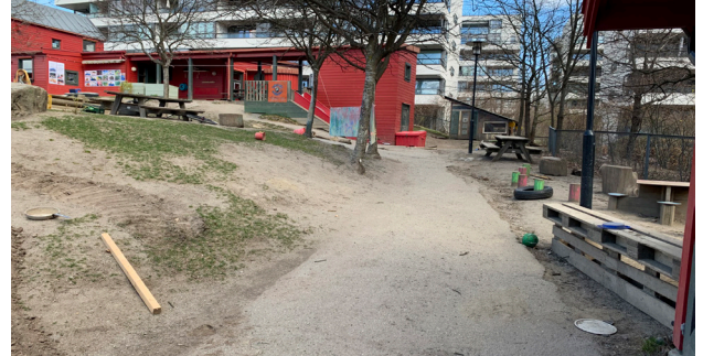
Gangsti fra porten og inn i barnehagen. Dekket bærer preg av aktiv bruk, med behov for vedligeholdsarbeid på dekkene.
