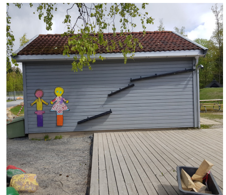
Vannrenner på vegg.
