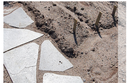
Tråkkheller er lagt inni parsellene.
