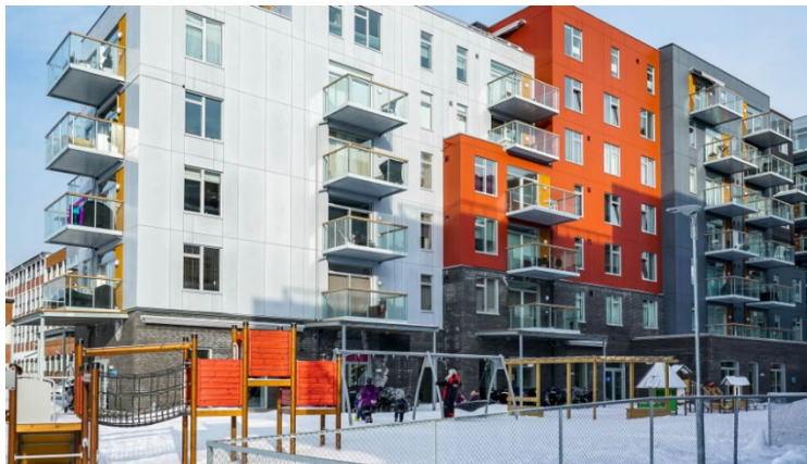
Figur 4-1: Brødfabrikken. Tilgjengelig fra: https://www.soeiendom.no/om-oss/ (hentet 01.06.2020)
