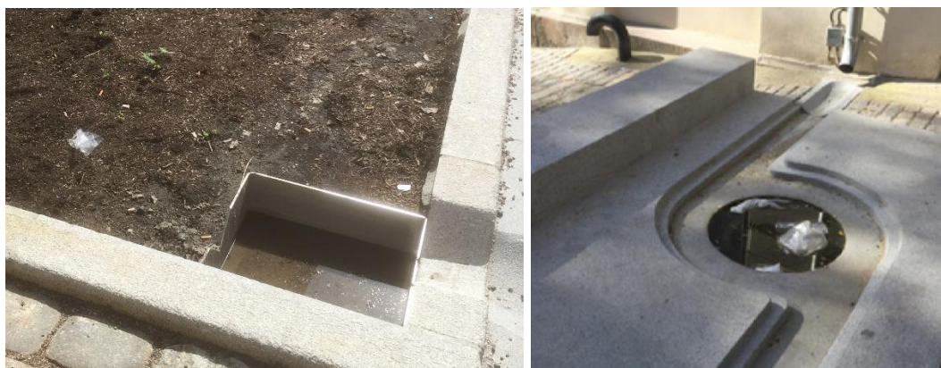
Bilde 3.3: Løv, sedimenter og søppel i innløpskasser og kunstelementer i april/mai 2017 (Foto: Gerd Minde, Braathen Landskapsentreprenør AS).
