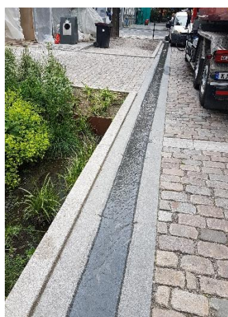
Bilde 2.8: Vannet ble ført fra brannslangen til den konstruerte flomveien.
