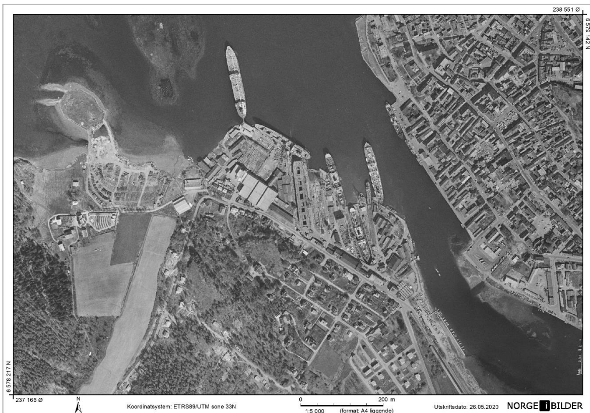
Figur 27 Transformasjonsområdet i Tønsberg i 1979. (Norgebilder.no).
