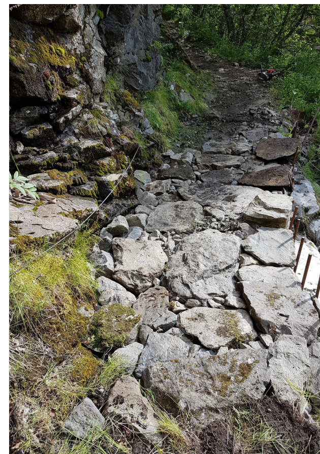
Figur 39. Steinlegging langs vegen (Foto: Venner av Aurlandsdalen)
