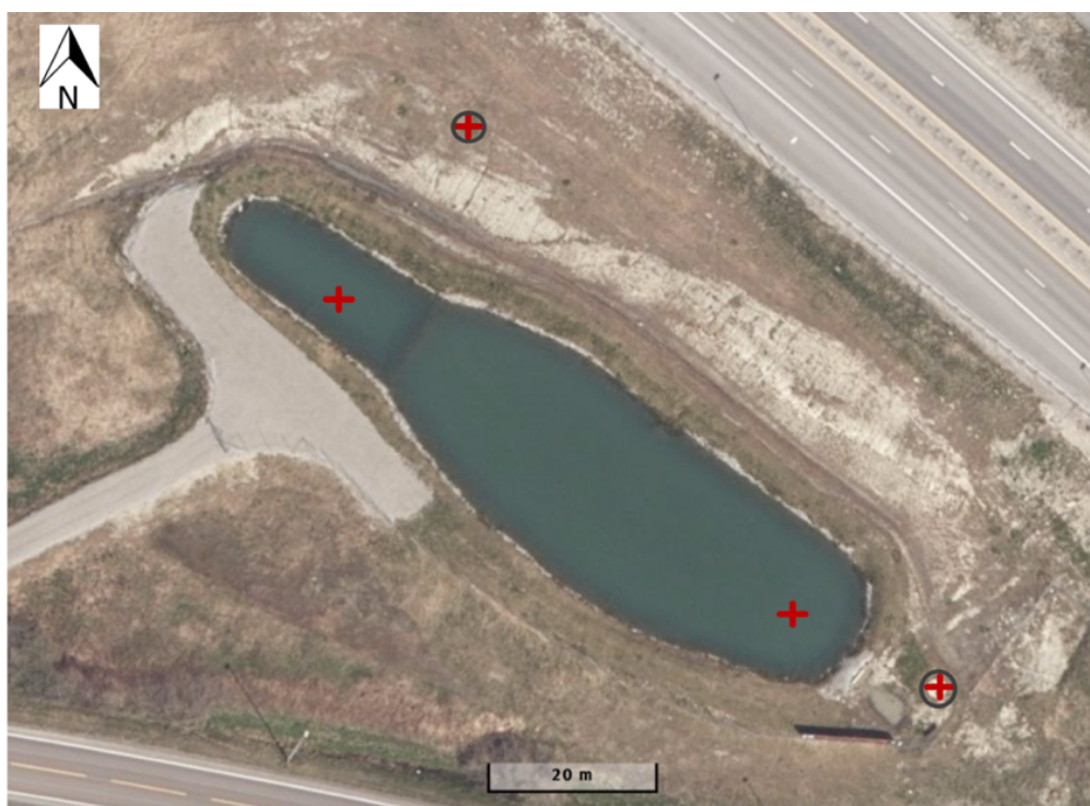
Figur 7: Oversiktsbilde over Fossbekken rensedam og prøvetakingspunkter. De sorte sirklene markerer kummene, innløpskum nord på kartet og utløpskum sørøst på kartet. De røde kryssene symboliserer prøvetakingspunktene. En kan også se terskelen som skiller forsedimentasjonsbassenget og hovedsedimentasjonsbassenget i rensedammen (Norgeskart 2019a).
