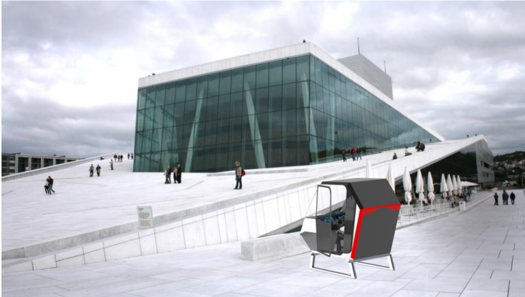
Figur 12.7: Dolphin Sky på operataket i Oslo. (129)
