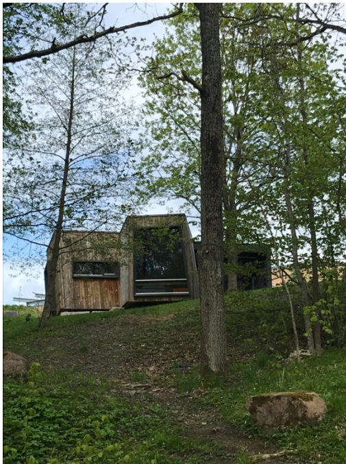
Figur 2 Friluftssykehuset sett fra Gaustadbekken.
