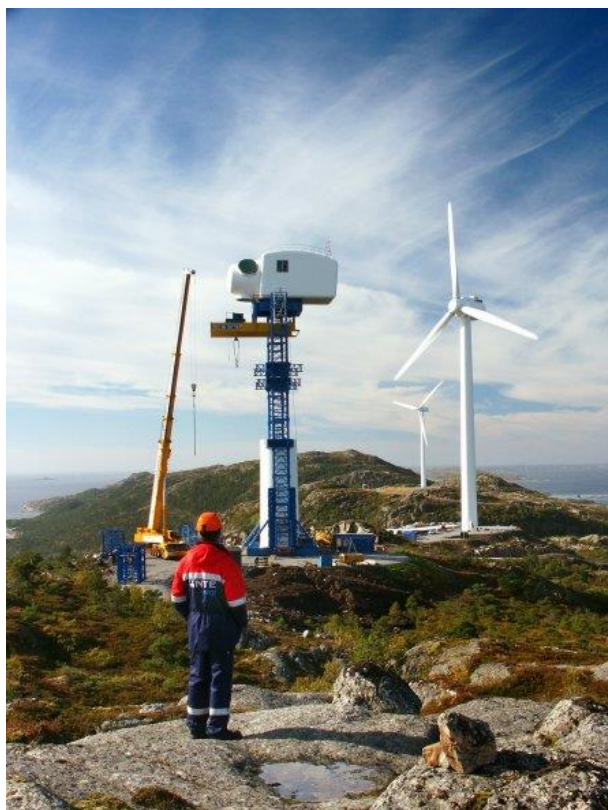
Figur 7: Montering av turbiner på Hundhammerfjellet ved hjelp av løftetårn. [7]
