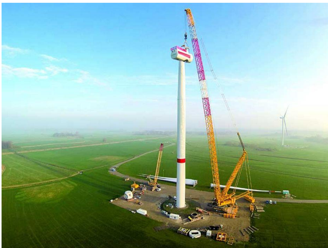
Figur 8: Montering og demontering av vindturbiner krever stadig større og kompliserte kraner (Moser, 2016).
