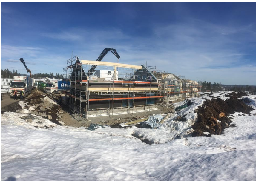
Figur 16: Heising av huselementer på byggeplass
